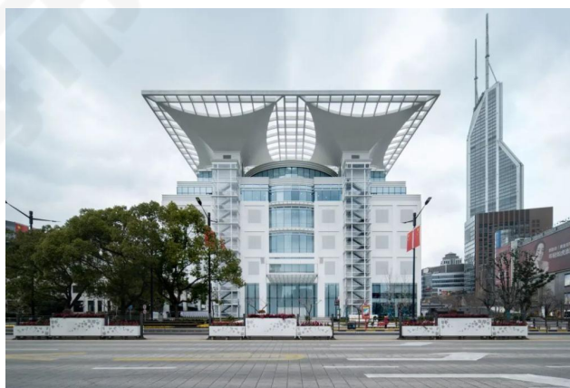
图 5.42 上海城市规划展示馆改扩建工程实景
