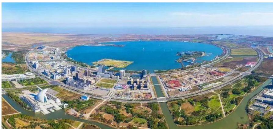
图4.12 临港新片区超低能耗集中示范区
