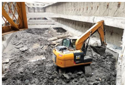
图5.14 远程控制基坑挖掘机器人
