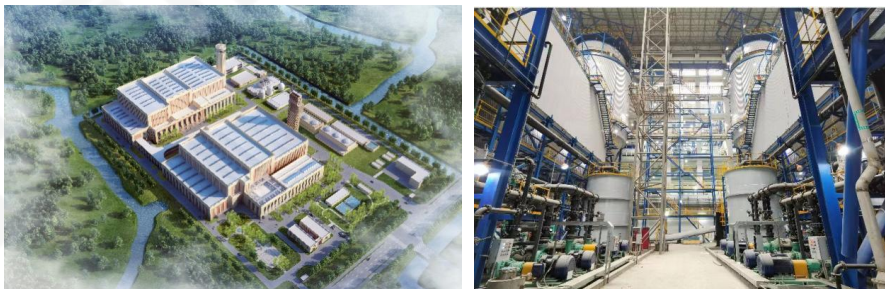
图 6.6 上海天马生活垃圾末端处置综合利用中心
