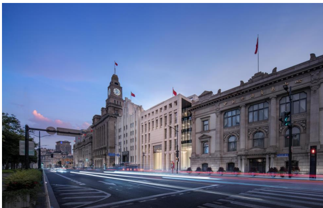
图 5.46 上海外滩国际大楼改造项目实景
