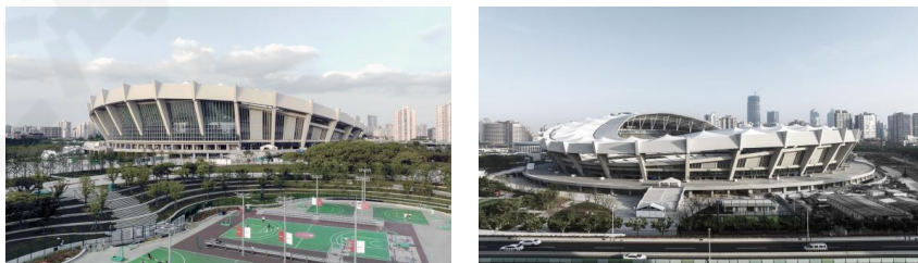
图 5.38 2021 年 FIFA 世俱杯上海体育场整体改造项目实景
