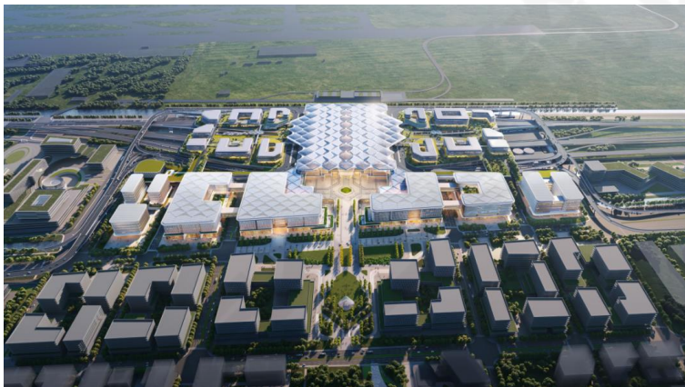
图 4.4 东方枢纽上海东站
