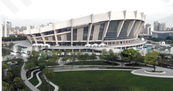
图 5.41 改造后体育场海绵城市设施（下凹绿地）
